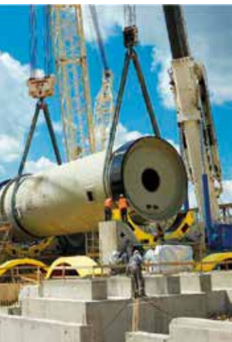
Rys. 15. Fundament młyna nr 4 w Cementowni Górażdże
