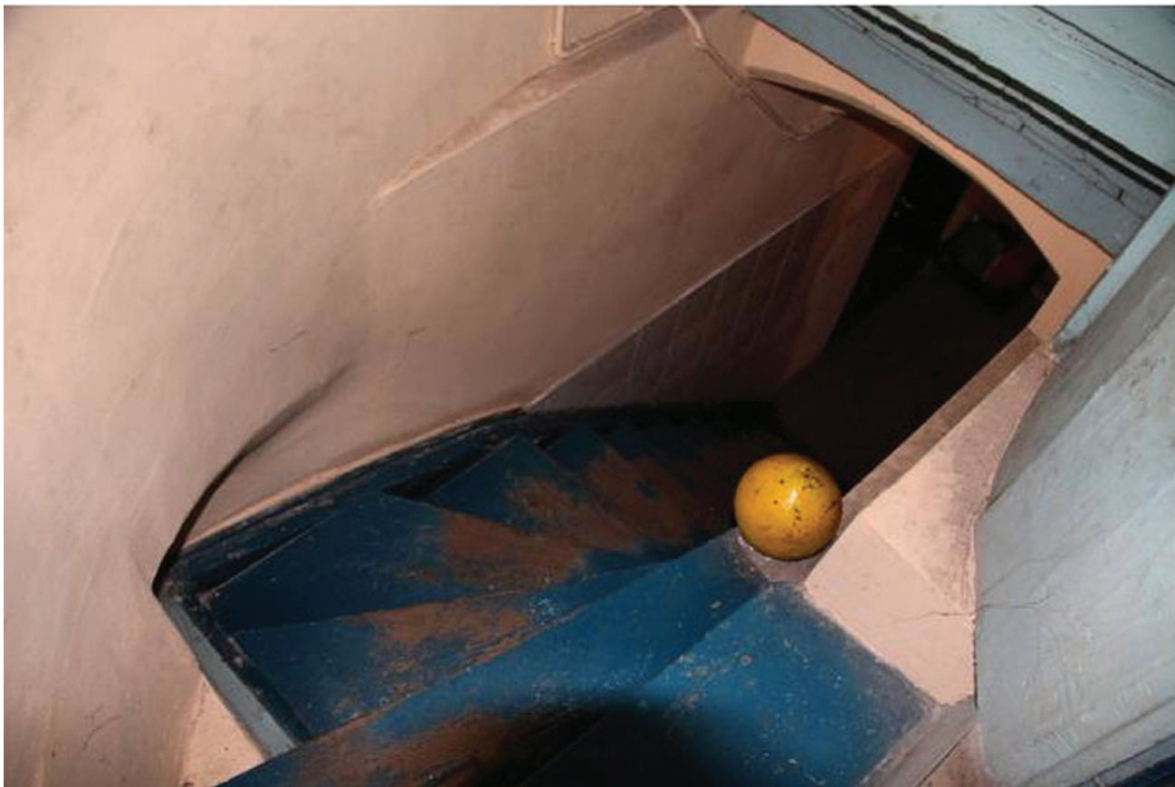
Fot. 4. Betonowo-stukowa kula w dworze w Rzetni (fotografia własna autora 2018 r.)
