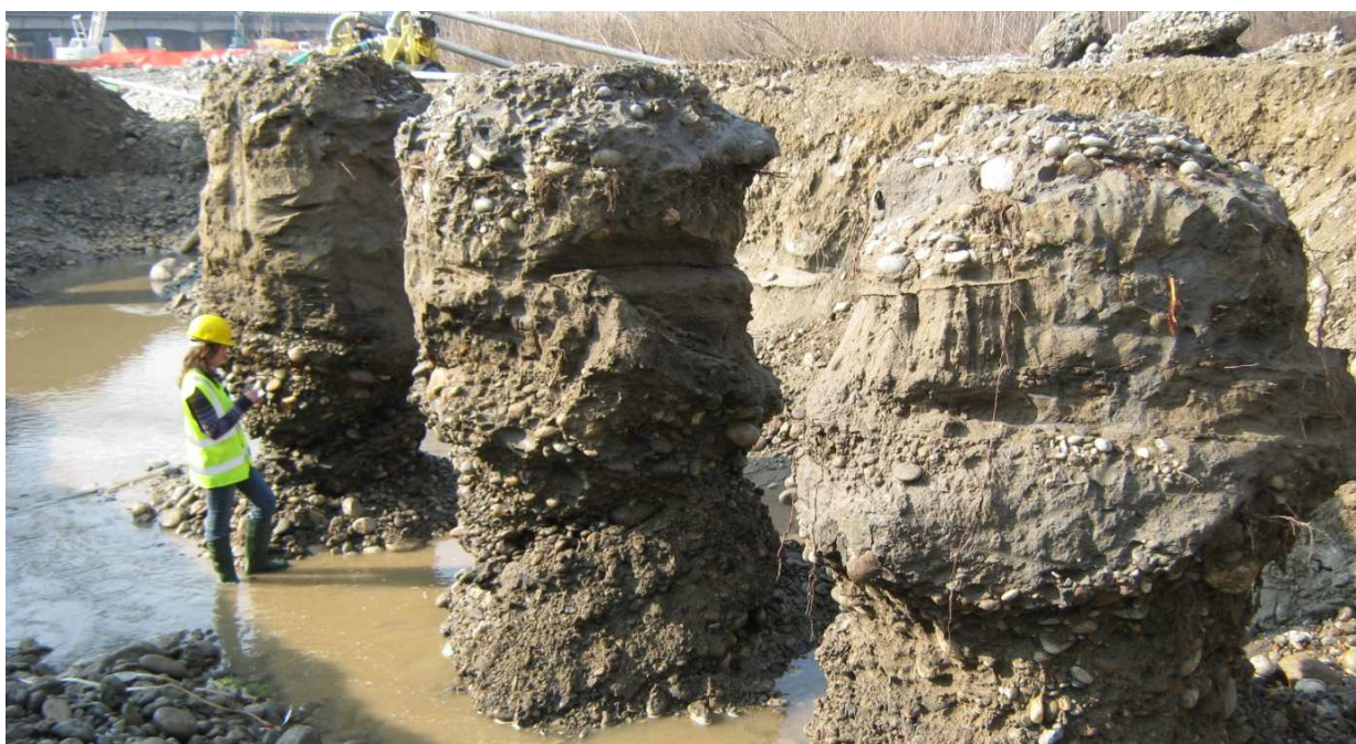
Rys. 8. Odsłonięte kolumny iniekcyjne –system dwustrumieniowy (Flora i in., 2012)
