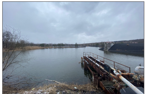
Fot. 4. Knurów – zbiornik wodny przy kopalni „Knurów-Szczygłowice” (fot. P. Pala)
