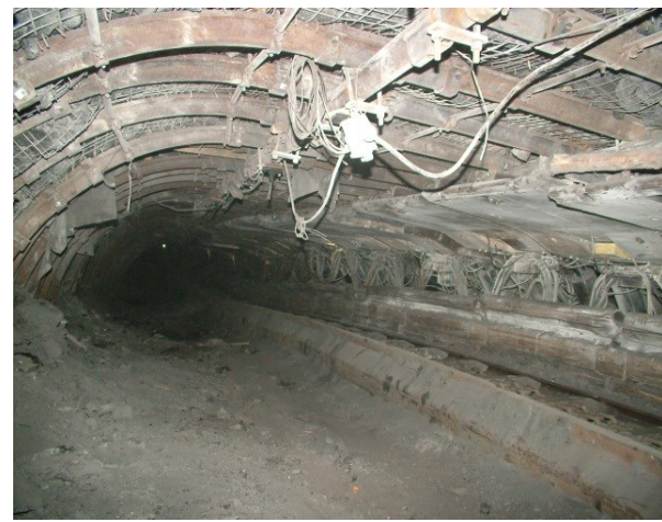
Rys. 42.15. Widok pracy podciągu i kotwi strunowej wzmocniającej odrzwia ŁPro/B/7-7/5,9/2,4/V32 ściany 22-C3
