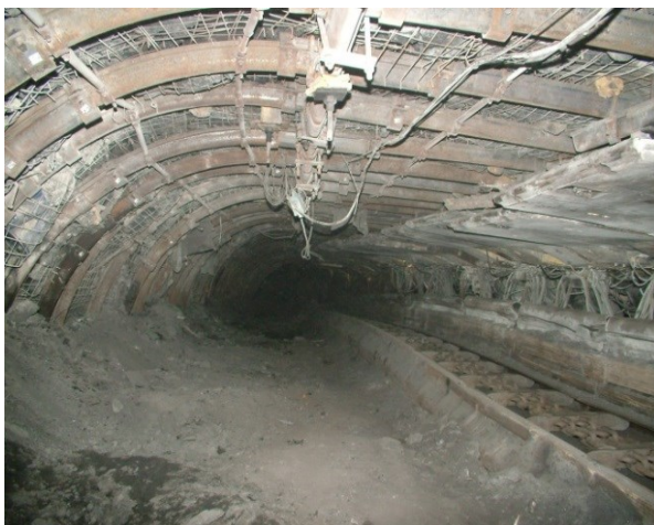
Rys. 42.14. Widok odrzwi obudowy łukowo-prostej ŁPro/B/7-7/5,9/2,4/V32 dla rozcinki likwidacyjnej ściany 22-C3
