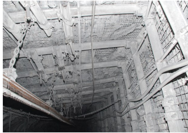
Rys. 42.17 Widok pracy podciągu i kotwi strunowej wzmacniającej odrzwia ŁPro/B/7-7/5,9/2,4/V32 ściany 29 z chodnika podścianowego 29-C3
