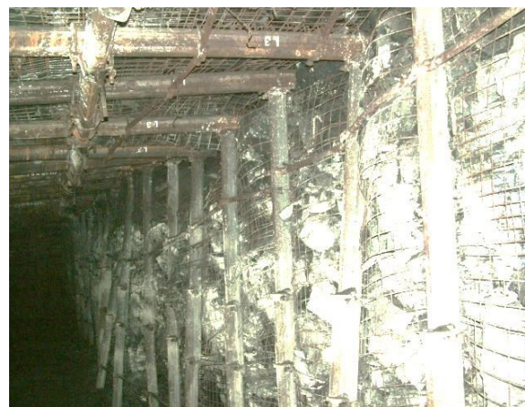
Rys. 42.9 Widok ociosu skalnego zabezpieczonego stojakami podporowymi SV29
