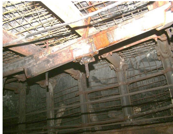
Rys. 42.13. Widok pracy podciągu i kotwi strunowej wzmocniającej odrzwia
