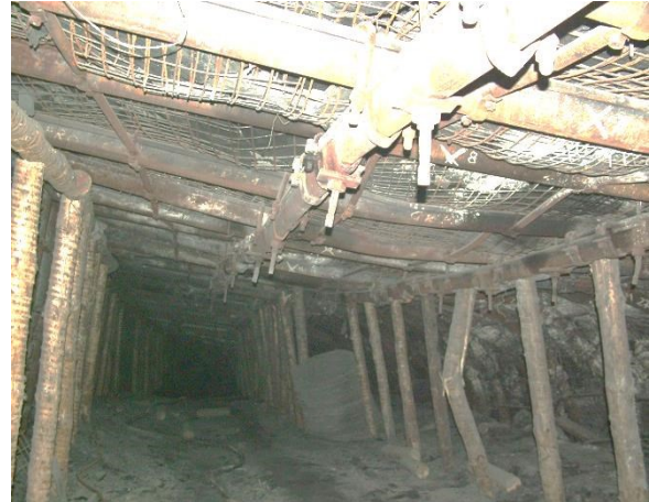
Rys. 42.11. Widok wzmocnienia odrzwi i zwiększonego obciążenia na odcinku podebrania ścianą
