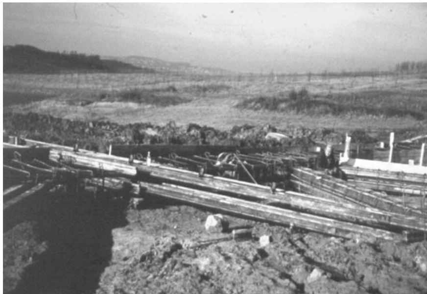
Rys. 4. Żelbetowy ruszt (fot. T. Paluch)
