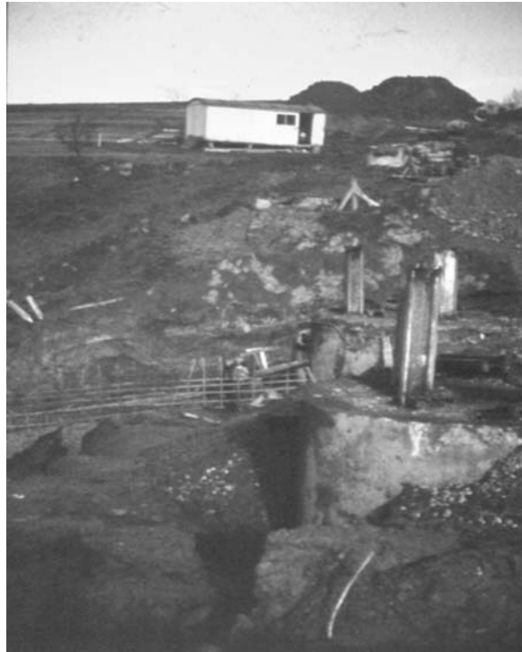
Rys. 5. Studnie – posadowienie głębokie (fot. T. Paluch)
