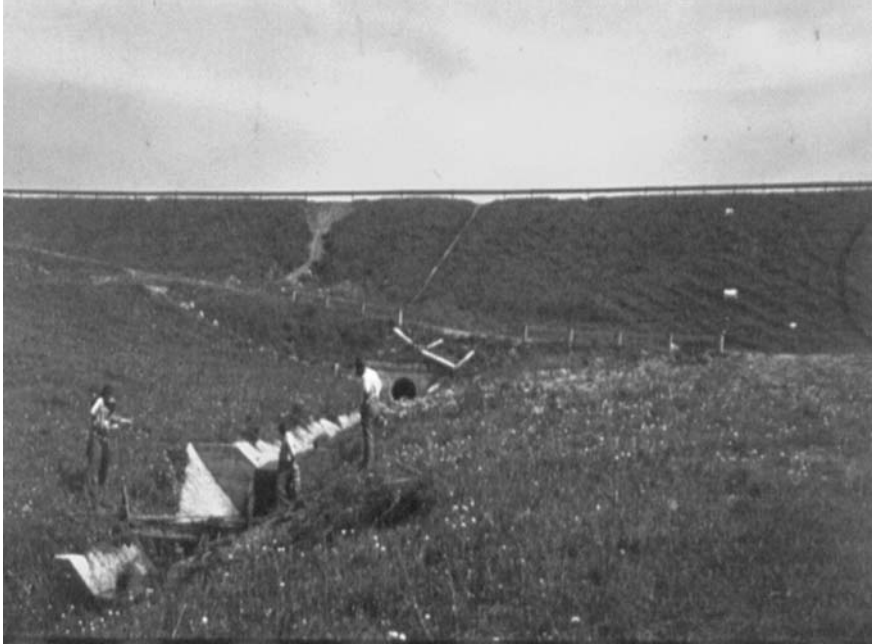
Rys. 3. Odwodnienie powierzchniowe terenu osuwiska (fot. T. Paluch)
