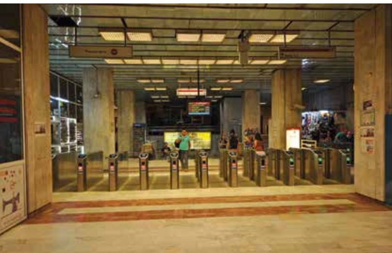
Stacja Lujerului na linii M3
