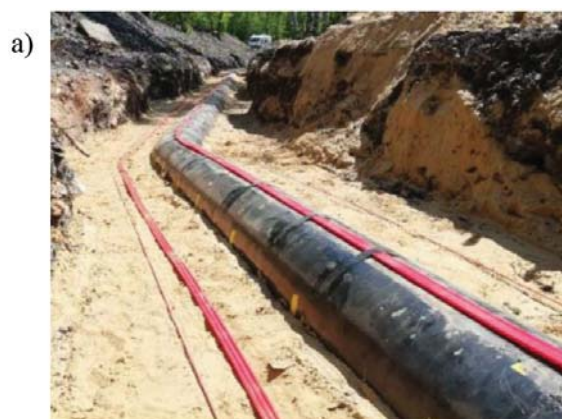
Rys. 19. a) Widok czujników światłowodowych do monitorowania pracy rurociągu oraz otaczającego go gruntu [21]; b) przykładowy rozkład temperatury na całej długości (180 m) w odniesieniu do referencyjnych pomiarów punktowych [26]
