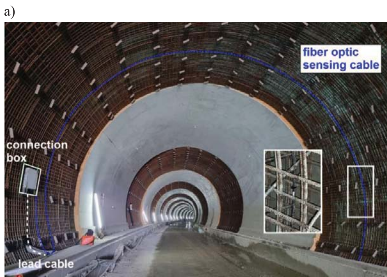
Rys. 17. a) Przykładowa instalacja światłowodowego czujnika DFOS w obrębie obudowy tunelu; b) przykładowy profil odkształceń obwodowych
