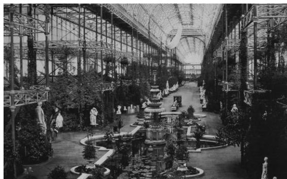
Rys. 6. Wnętrze Pałacu Kryształowego w Londynie
