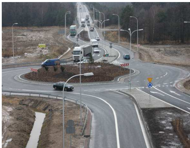
Fot. 1. Fotografia ronda turbinowego przy zjeździe na węzle „Prądy” z autostrady A4 na drogę Opole – Nysa
