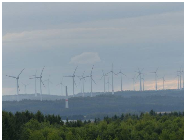
Fot. 1. Widok farmy wiatrowej w Hunsrück Photo 1. Wind farm in Hunsrück
