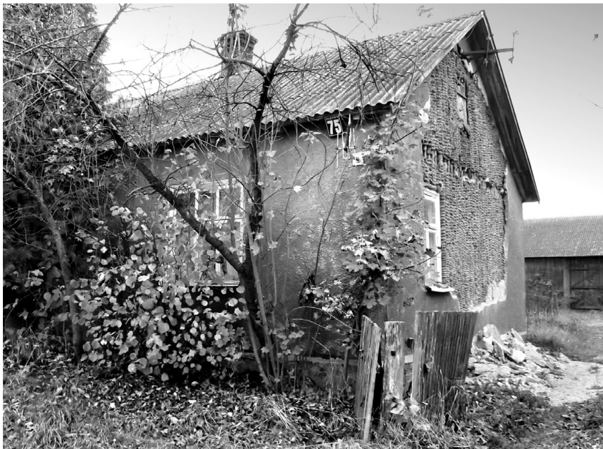
Ryc. 10. Dom nr 75 we wsi Olendy, z widoczną strychulcową konstrukcją ścian; fot. A. Biernacka i N. Garwolińska
