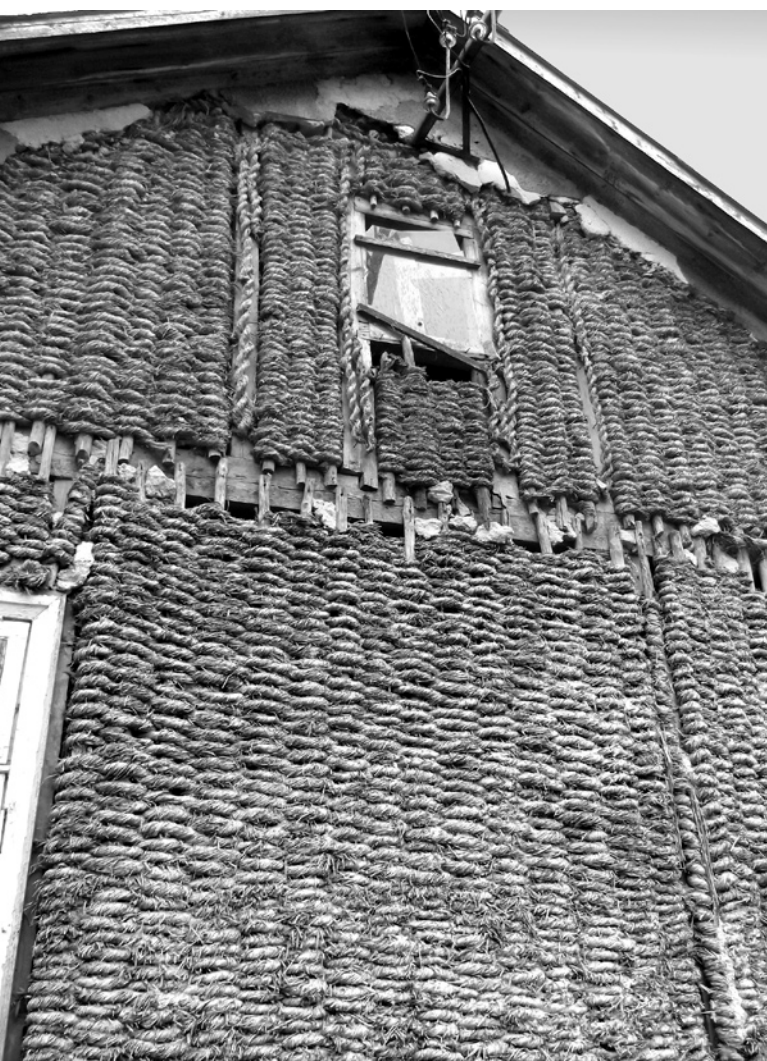
Ryc. 1. Strychulcowa konstrukcja ściany domu nr 75 we wsi Oleny; fot. A. Biernacka i N. Garwolińska
