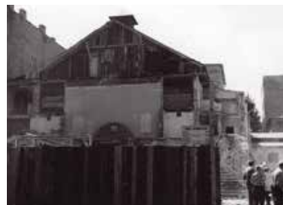
Fot. 6. Przebudowa teatru Jaracza (1960); źródło: [23]
