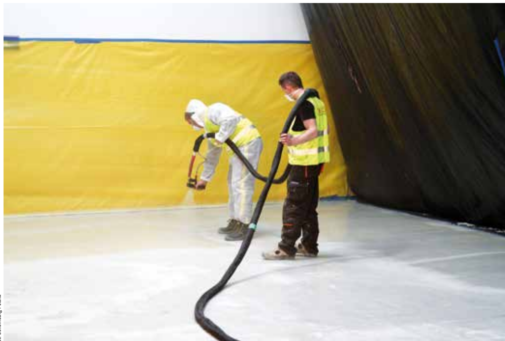
Wykonanie chemoodpornej antypoślizgowej posadzki przemysłowej w systemie GEPOTECH
