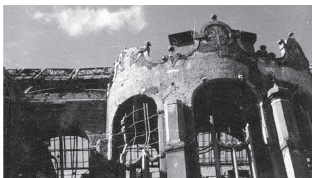
Fot. 8. Rezultat ostrzału Gmachu Głównego Politechniki Gdańskiej – zniszczone główne klatki schodowe [6]
