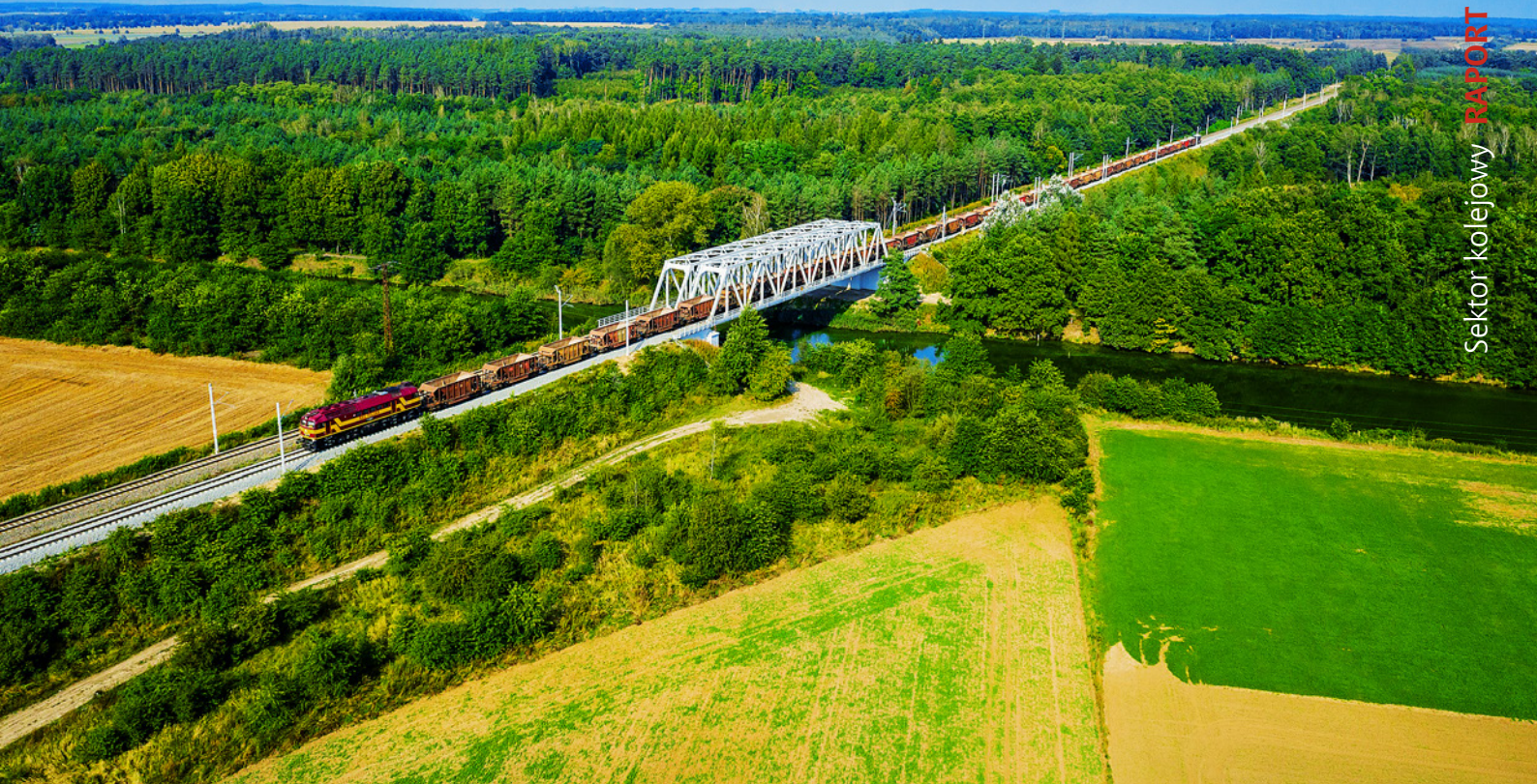
Most przez Kanał Gliwcki po modernizacji, fot. S. Grochowski, PKP Polskie Linie Kolejowe S.A.
