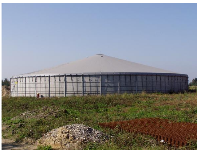
Rys. 2.1. Przykryte zbiorniki na gnojowicę, jako skuteczna bariera dla emisji gazów (fot. J. Dach)
