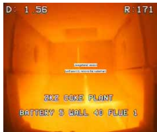
Rys. 12 Zdjęcie wnętrza kanału grzewczego obrazujące przesys gazu surowego z komory koksowniczej do układu grzewczego na jednej z ocenianych baterii koksowniczych.
