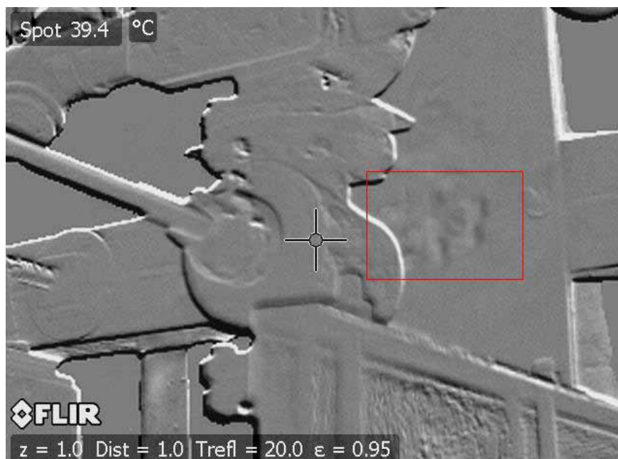
Rys. 11 Przykład zastosowania kamery termowizyjnej do oceny szczelności instalacji gazowej (czerwonym prostokątem zaznaczono ujawniony wpływ gazu opałowego)
