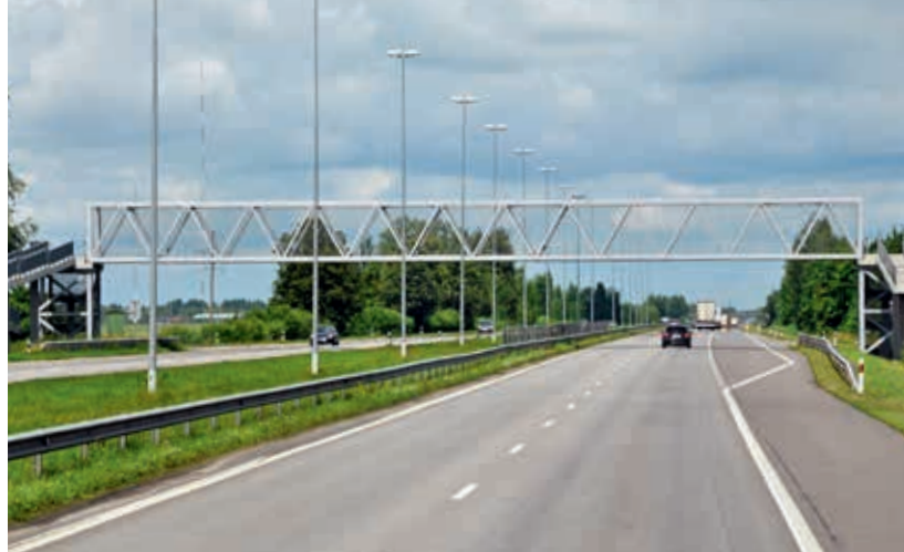
Stalowa kładka dla pieszych nad autostradą Kowno – Kłajpeda (obiekt nr 48)
