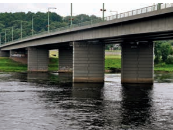
Sprężony, betonowy most belkowy przez Niemen w Kownie (obiekt nr 39)
