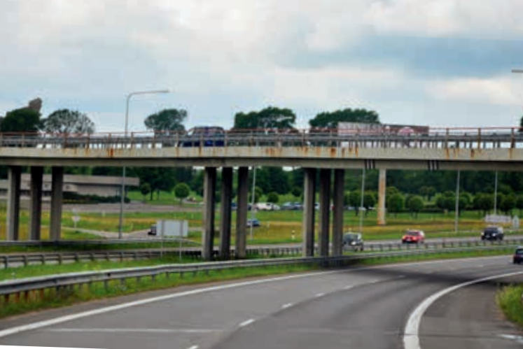
Żelbetowa estakada nad autostradą Kowno – Kłajpeda (obiekt nr 47)
