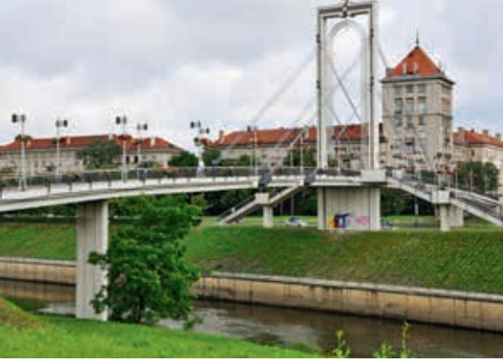
Podwieszona kładka dla pieszych przez odnogę Niemna w Kownie (obiekt nr 41)
