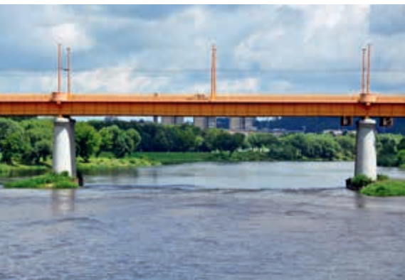
Stalowy most belkowy przez Wilię w Kownie (obiekt nr 45)
