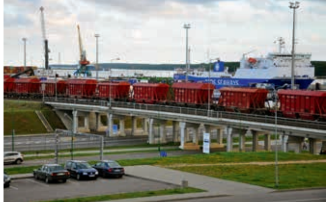
Betonowa estakada kolejowa przy porcie w Klaipėdzie (obiekt nr 52)
