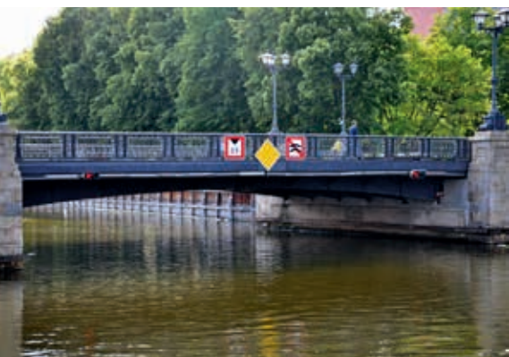
Stalowy most kłapowy przez Dangę w Klaipėdzie (obiekt nr 51)
