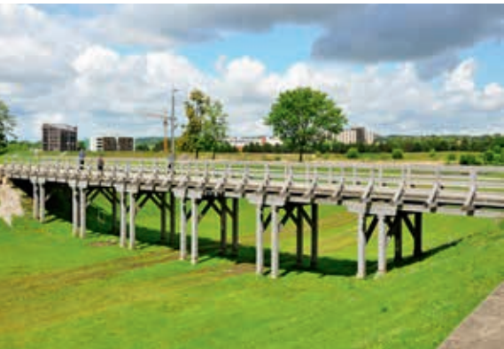
Drewniana estakada do zamku w Kownie (obiekt nr 44)
