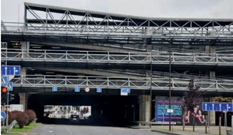
Parking wielopoziomowy w Kownie
