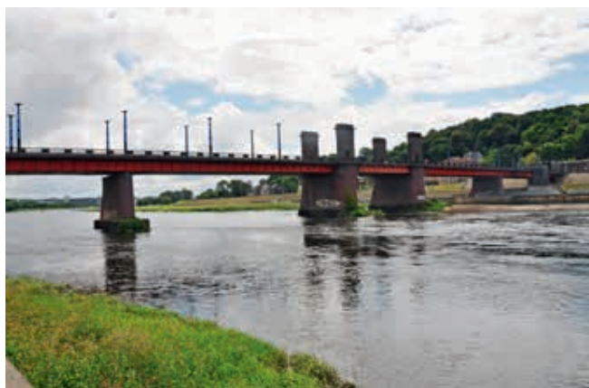
Stalowy most belkowy (tzw. czerwony) przez Niemen w Kownie (obiekt nr 43)
