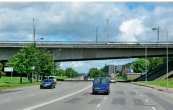
Betonowy, sprężony most belkowy przez Wilię i nad autostradą Kowno – Kłajpeda (obiekt nr 46)
