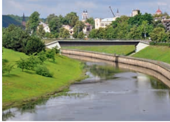
Stalowa kładka dla pieszych przez odnogę Niemna w Kownie (obiekt nr 42)
