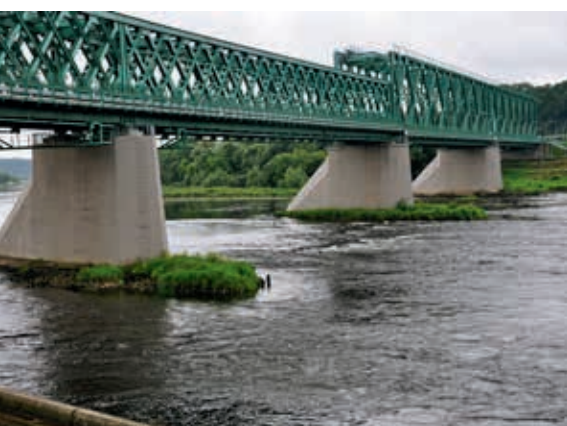
Stalowy most kolejowo-drogowy przez Niemen w Kownie (obiekt nr 38)
