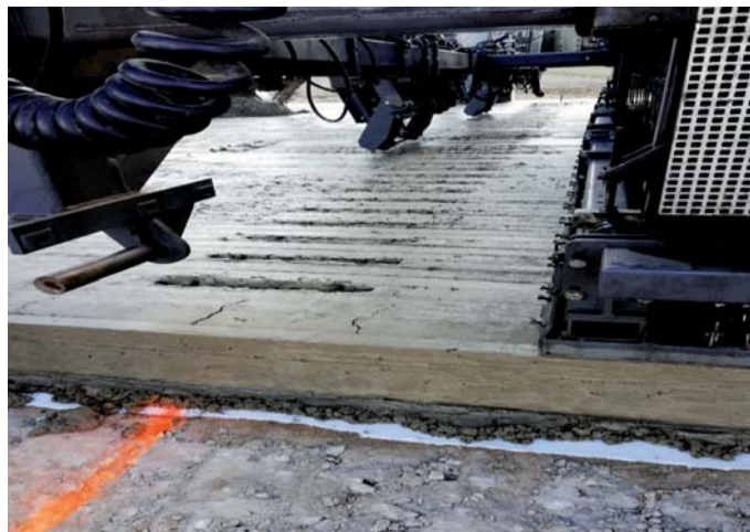
Fot. 6. Wwirowywanie dybli i kotew w świeży beton (fot. autora)
