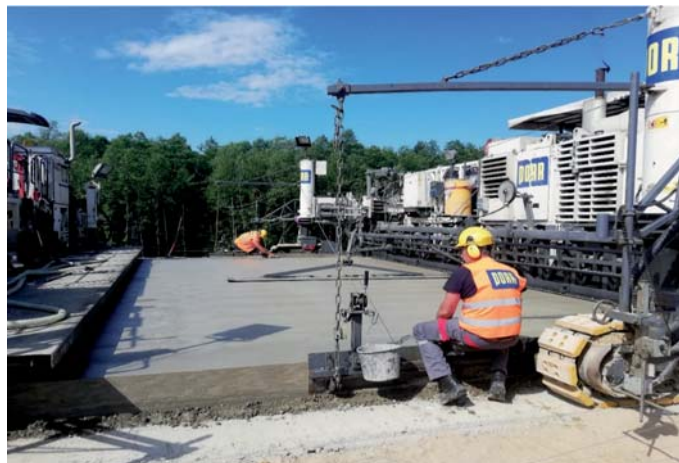
Fot. 5. Rozkładarka do górnej warstwy betonu (fot. autor)
