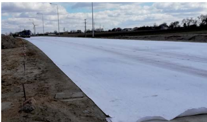
Fot. 4. Ułożenie geowłókniny (fot. autora)
