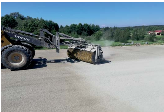
Fot. 8. Mechaniczne usuwanie zaczynu cementowego z nawierzchni (fot. autor)
