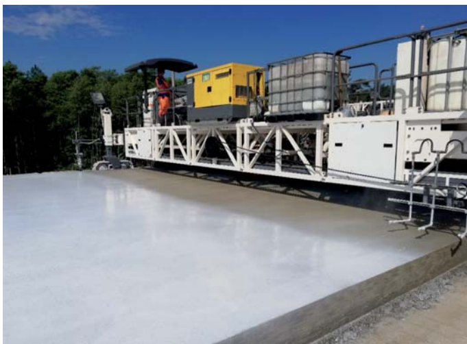
Fot. 7. Pomost roboczy do nanoszenia środka pielęgnacyjnego oraz opóźniającego wiązanie (fot. autor)
