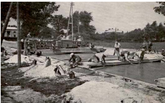
Fot. 1. Budowa drogi o nawierzchni z betonu cementowego na odcinku drogi krajowej Warszawa–Modlin, rok 1935 (źródło: Aleksander Kobyliński, „Die Landstraßen in Polen” miesięcznik „Die Straße”, rocznik 2, Nr 17 z 1 września 1935 r.
