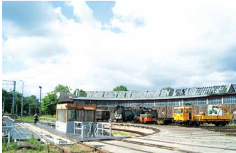
Parowozownia Skierniewice jest jedynym tego typu obiektem w Polsce stanowiącym własność organizacji pozarządowej
