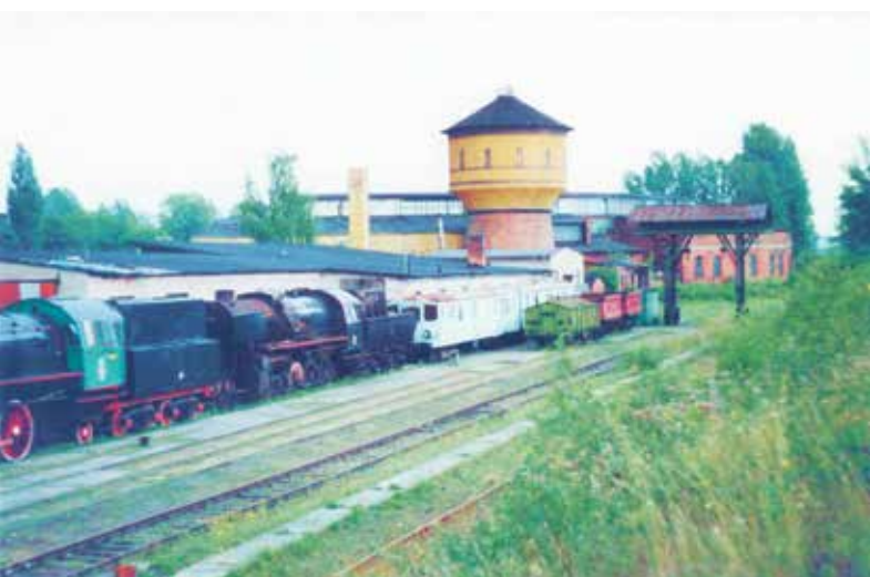
Skansen w Pyskowicach od wielu lat boryka się z uzyskaniem własnego domu. Obecnie mieści się w hali wagonowni z lewej. Widoczna z tyłu hala wachlarzowa kilka lat temu uległa zawaleniu
