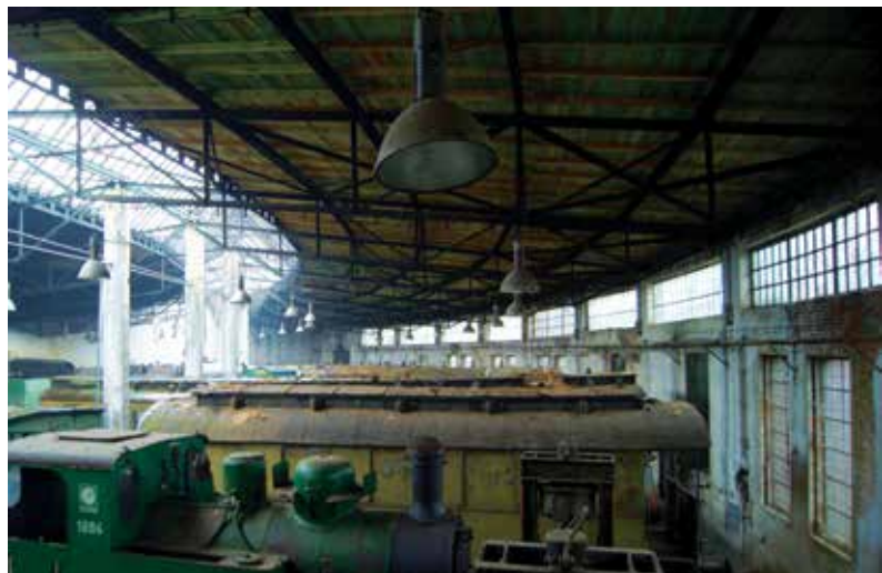
Ogromna hala skierniewickiej Parowozowni to jednak także duże wyzwanie remontowe i finansowe
