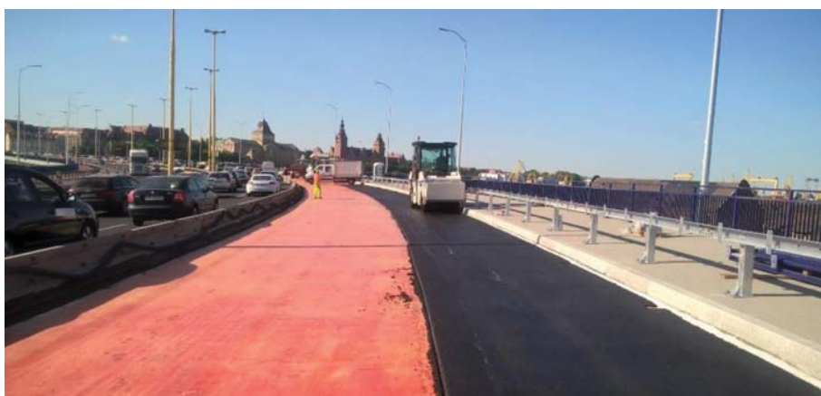
Fot. 2. Zagęszczanie warstwy ochronnej z mieszanki mastykowo-grysowej o zwiększonej zawartości mastyksu SMA-MA 8 PmB 65/105-60
