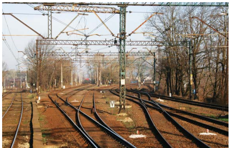
Fot. 2. Układ torów posterunku odgałęźnego Grabiszyn po powojennej przebudowie. Od lewej: dwa tory łącznicy z kierunku Wałbrzych/Głogów, dwa tory z Legnicy/Głogowa i jeden tor ze stacji towarowej na wrocławskim Gądowie zbiegają się w jeden rozjazd (bliski miejscu wykonania zdjęcia). Z prawej strony – dwa tory w kierunku północnym, które niezależnie prowadzone są aż do dworca Głównego. Fot. B. Molecki
