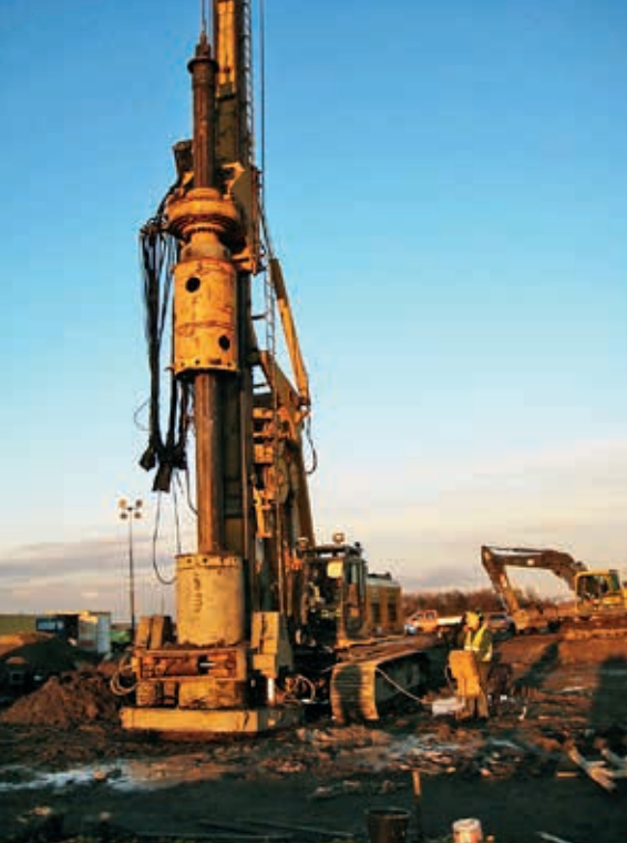
Pale wielkośrednicowe wiercone w rurze obsadowej – budowa farmy wiatrowej Krobia Południe
