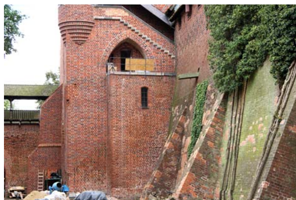
Ryc. 19. Wieża Klesza na Zamku Wysokim w Malborku. Dolny fragment elewacji zachodniej (fot. M. Prarat, 2015)
