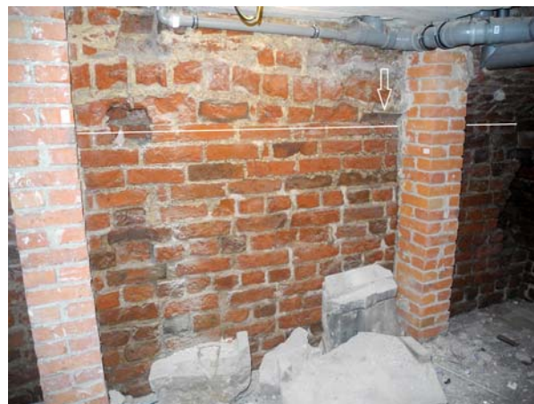
Ryc. 23. Wieża Klesza na Zamku Wysokim w Malborku. Piwnica, pomieszczenie nr 02. Ściana południowa. Widoczna granica sklepienia kolebkowego, które zostało skute (fot. M. Prarat, 2015)
