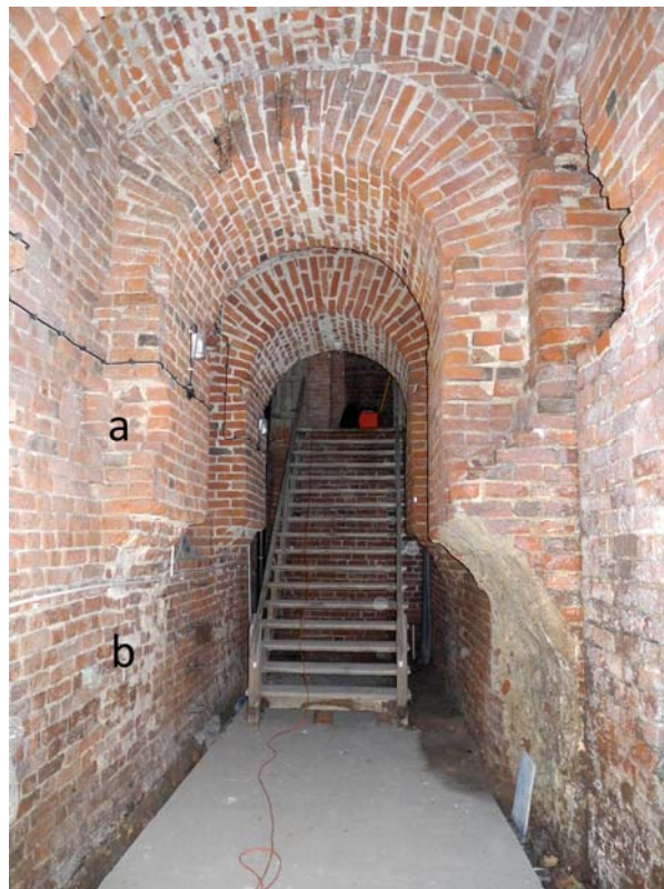
Ryc. 3. Wieża Klesza na Zamku Wysokim w Malborku. Najniższa kondygnacja piwnicy, widok w kierunku zachodnim. Oznaczenia: a – wtórnie wykonane gniazdo w filarze, b – skuta powierzchnia filara (fot. M. Prarat, 2015)
