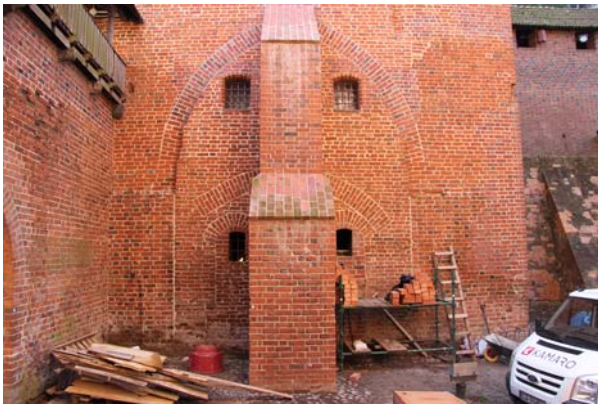
Ryc. 16. Wieża Klesza na Zamku Wysokim w Malborku. Dolny fragment elewacji północnej (fot. M. Prarat, 2015)
