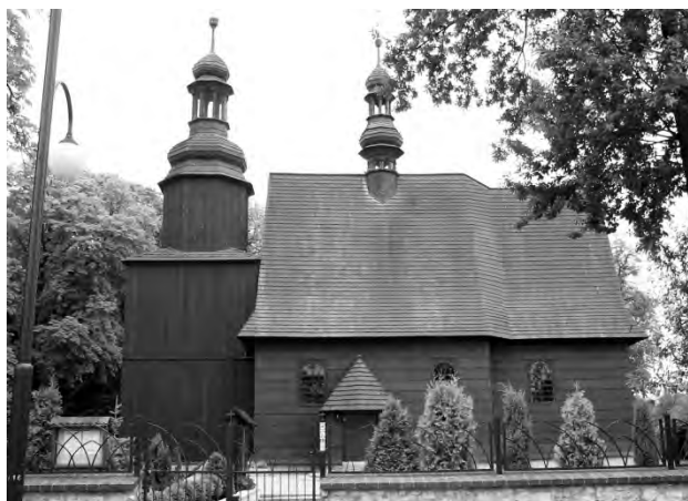
Widok kościoła od strony ulicy Kozielskiej [5]
