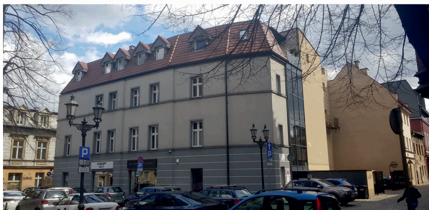
Fot. 1. Kamienica z XIII w., ul. Plebańska 11, Gliwice – zdjęcia porównawcze – przed realizacją i po remoncie, elewacja frontowa; źródło: fot. arch. ML-BUD i R. Fross, 2013, 2022
