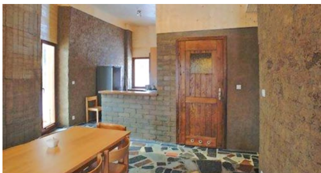
Rys. 9. Wewnętrzne docieplenie bloczkami słomiano-glinianymi ścian wykonanych w technice ziemi ubijanej w budynku w Pasłęku; źródło: https://sztuka-architektury.pl/article/4004/dom-wykonany-z-gliny
