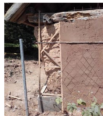
Rys. 1. Fragment ściany glinianej podlegającej naturalnej erozji pod wpływem penetrującej wody opadowej oraz cyklem zamarzania i odmarzania; proces rekonstrukcji i naprawy ściany glinianej lokalnym materiałem; źródło: http://www.ptsop.org.pl/ocalic-dziki-pszczoly/
