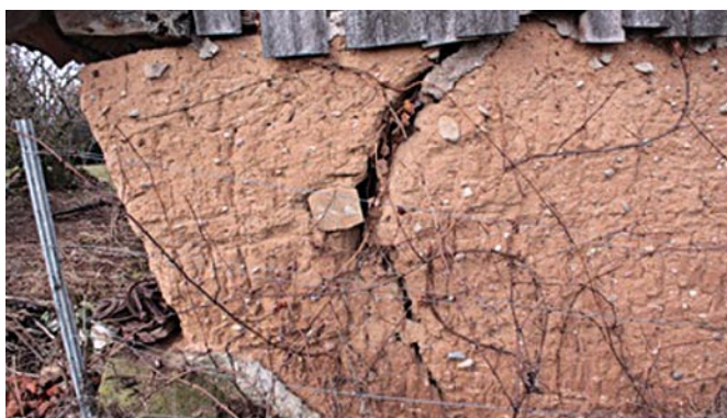
Rys. 1. Fragment ściany glinianej podlegającej naturalnej erozji pod wpływem penetrującej wody opadowej oraz cyklem zamarzania i odmarzania; proces rekonstrukcji i naprawy ściany glinianej lokalnym materiałem; źródło: http://www.ptsop.org.pl/ocalic-dziki-pszczoly/
