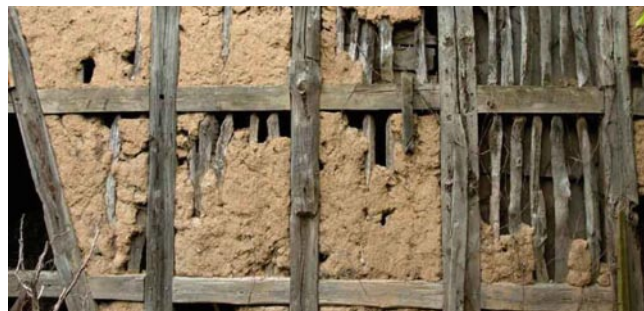
Rys. 2. Fragment ściany zewnętrznej stodoły z 1912 r., zbudowanej w systemie ryglowym z belek sosnowych z wypełnieniem pól wewnętrznych surową gliną wymieszaną ze słomą; źródło: https://dominatura.pl/2017/05/stara-stodola-konstrukcja-ryglowa/
