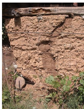
Rys. 1. Fragment ściany glinianej podlegającej naturalnej erozji pod wpływem penetrującej wody opadowej oraz cyklem zamarzania i odmarzania; proces rekonstrukcji i naprawy ściany glinianej lokalnym materiałem; źródło: http://www.ptsop.org.pl/ocalic-dziki-pszczoly/
