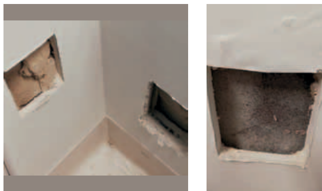
Rys. 1. Przykład błędnego podejścia do termoizolacji od wewnątrz, przemiarzenie muru widoczne zmiany mykologiczne na powierzchni muru
