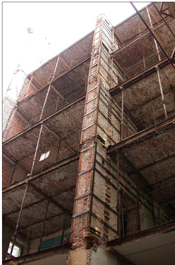
Ryc. 9. Wzmocnienie tymczasowe konstrukcji budynku; fot. P. Przybysz.
