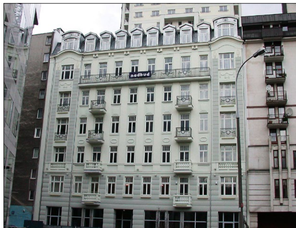
Ryc. 10. Elewacja frontowa budynku po zakończeniu rewitalizacji; fot. P. Przybysz.
