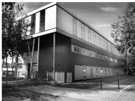
Fot. 3. Budynek Instytutu Inżynierii Lądowej. Siedziba Katedry Dróg i Lotnisk oraz Zakładu Infrastruktury Transportu Szynowego
