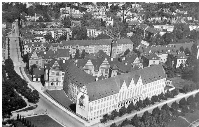
Fot. 1. Widok Gmachu Głównego uczelni z 1932 roku [1]
