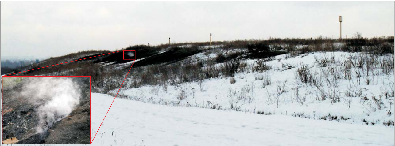
Ryc. 9. Wysoka aktywność termiczna północnej skarpy składowiska w styczniu 2013 r. uwidoczniła brakiem pokrywy śnieżnej i wydobywającym się dymem. Fot. J. Janeczek
