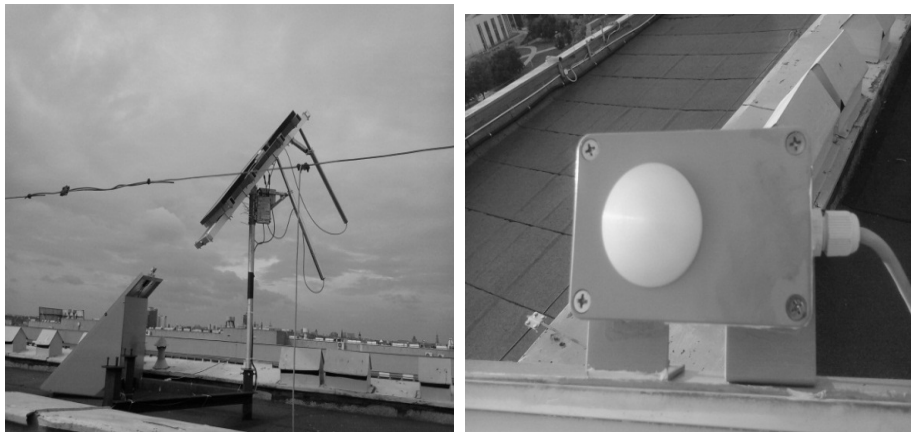
Rys. 1. Widok przygotowanego stanowiska badawczego wyposażonego w krzemowy czujnik gęstości mocy promieniowania słonecznego
