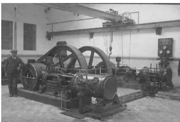
Rys. 3. Wnętrze elektrowni miejskiej w Lublinie
