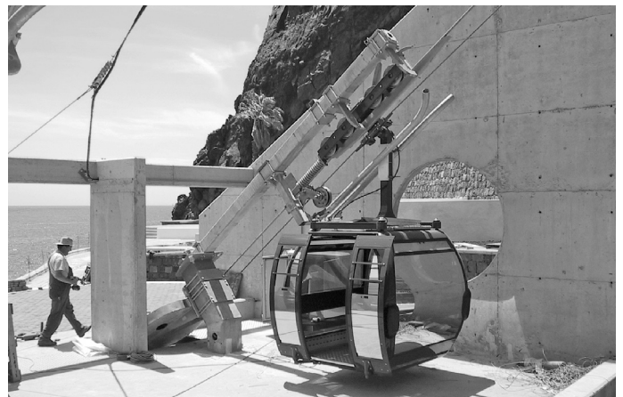
Fot. 2. Stacja napinająca kolei dwulinowej z kabinami 26 osobowymi [2]
