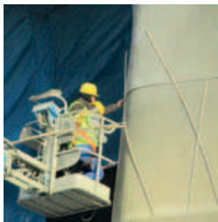
Rys. 8. Proces etapowego nanoszenia betonu natryskowego
