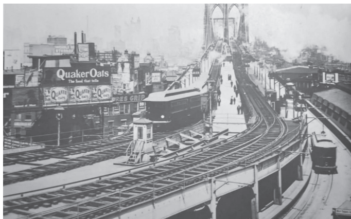
Rys. 2. Widok na stację po wschodniej części mostu Źródło: [4]
