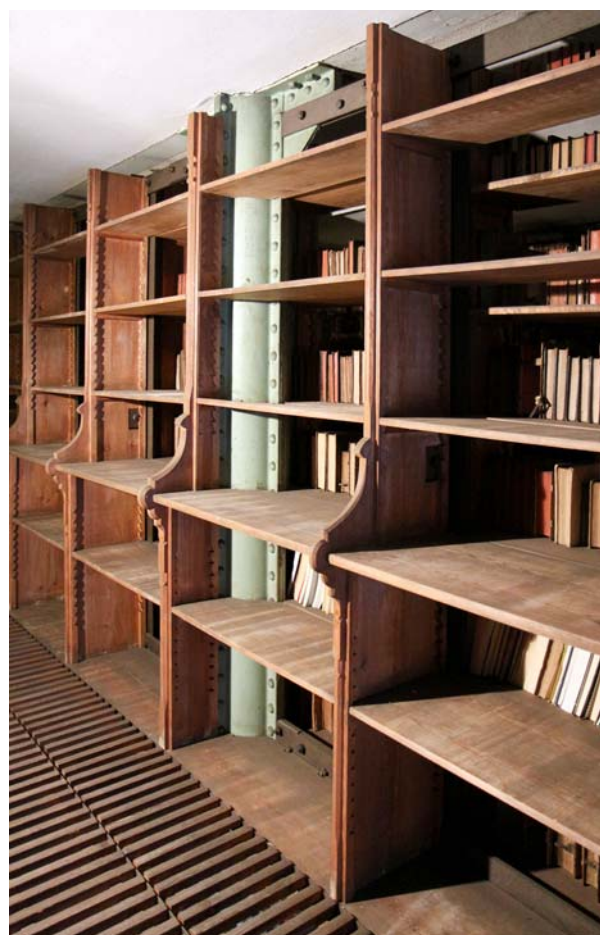
Ryc. 8. Wnętrze magazynu Biblioteki Kapitulnej na parterze, ul. Kanonia 12–14 we Wrocławiu. Regały i podesty na poziomie antresoli połączone z konstrukcją z żelaznych słupów. Fot. A. Gryglewska, 2018
