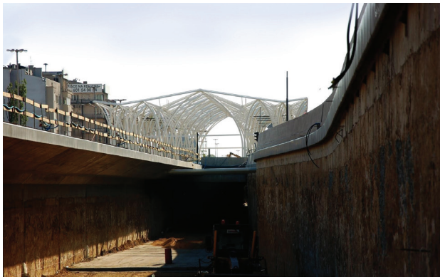
Il. 2. Ostatnia fazy przebudowy trasy W–Z (budowa tunelu), 2015 (fot. A. Pawłowska)
