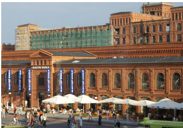
Il. 5. Centrum Kulturalno-Rozrywkowo-Biznesowe Manufaktura, 2006 – widok na hotel Andel's w budowie (fot. A. Pawłowska)
