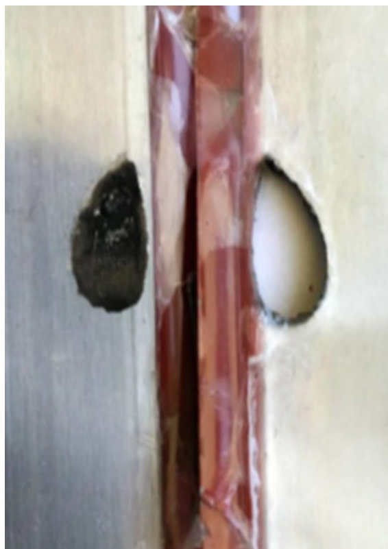
Rys. 4. Widok działania pierwotnej przyczyny awarii i źródło zwarcia międzyzwojowego (fot. serwisu producenta)
