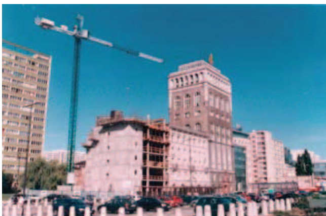
Rys. 3. Ocena stanu technicznego budynku zabytkowego PAST-y w Warszawie
