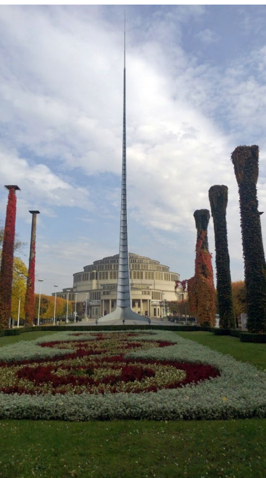
Ryc. 6. Iglica przed Halą Stulecia we Wrocławiu (fot. B. Podhalański)
