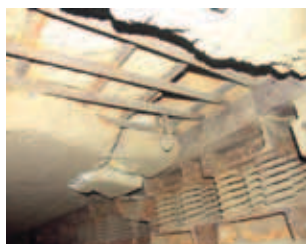
Rys. 4, 5. Uszkodzenia bocznej powierzchni bloku podkowiadłowego; spękania, ubytki betonu, odsłonięte pręty zbrojenia; uszkodzenia dolnej powierzchni fundamentu – odspojone luźne fragmenty betonu, odsłonięte i korodujące zbrojenie dolne, w tle uszkodzony wibroizolator GM
