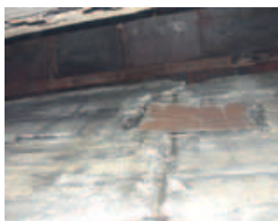
Rys. 4, 5. Uszkodzenia bocznej powierzchni bloku podkowiadłowego; spękania, ubytki betonu, odsłonięte pręty zbrojenia; uszkodzenia dolnej powierzchni fundamentu – odspojone luźne fragmenty betonu, odsłonięte i korodujące zbrojenie dolne, w tle uszkodzony wibroizolator GM
