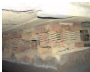
Rys. 6, 7. Uszkodzone i korodujące sprężyny w typowych wibroizolatorach MP pod fundamentem młota MPM 5000; całkowicie zniszczony wibroizolator GM-8 pod blokiem podkowiadłowym młota; korozja elementów stalowych wibroizolacji
