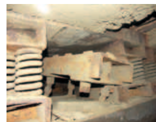
Rys. 6, 7. Uszkodzone i korodujące sprężyny w typowych wibroizolatorach MP pod fundamentem młota MPM 5000; całkowicie zniszczony wibroizolator GM-8 pod blokiem podkowiadłowym młota; korozja elementów stalowych wibroizolacji
