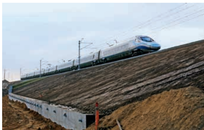
Ryc. 14. Odbudowany nasyp od strony osuwiska
