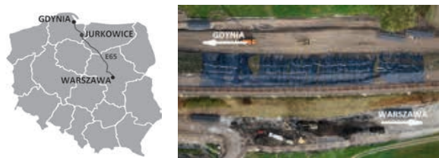
Ryc. 1. Linia E65 na odcinku Warszawa – Gdynia z zaznaczeniem miejscowości Jurkowie (koło Malborka). Zdjęcie fotogrametryczne analizowanego nasypu, wyk. Geopartner Sp. z o.o.
