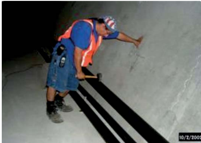
Rys. 1. Kontrola dźwiękowa młotkiem zewnętrznych kabli sprężających w skrzynkowym dźwigarze mostowym [Corven Engineering Inc.]
