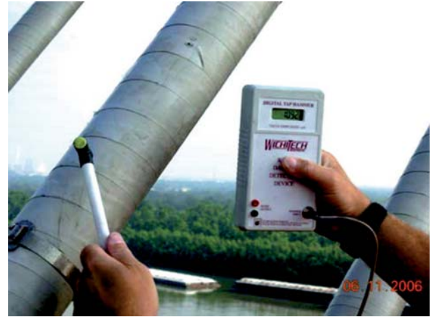
Rys. 2. Kontrola przez ostukiwanie stanu osłony kabla podwieszającego [8]
