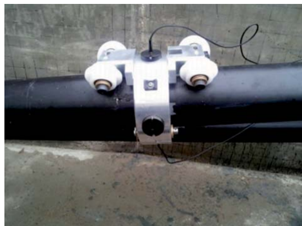
Rys. 9. Zmotoryzowany system ultradźwięków małej częstotliwości (LUFT) w czasie badania kabla zewnętrznego [3]
