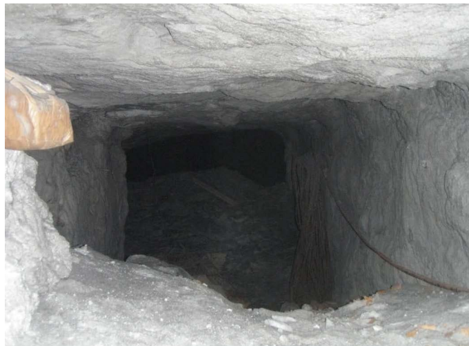
Rys. 4. Zasypany fragment przekopu
