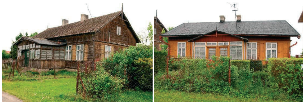
Fot. 3., Fot. 4. Kraszew, dawne domy letniskowe (fot. autor, 2013 r.)
