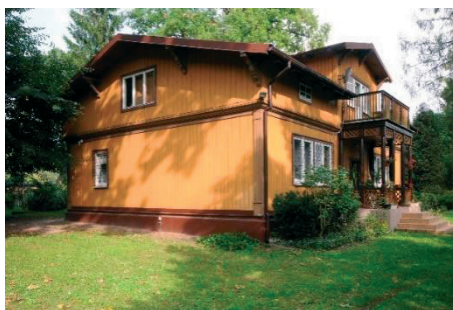
Fot. 5. Sokolniki, dworek myśliwski Scheiblerów z 1888 r. (fot. autor, 2015 r.)
