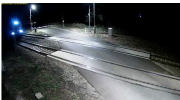
Fot.1. Widok przejazdu kat. A i zbliżającego się pociągu [źródło: system monitoringu PKP PLK S.A. linii nr 132]
