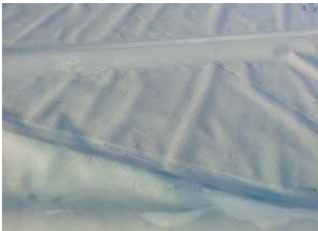
Fot. 1. Przykrycie grubą folią budowlaną
