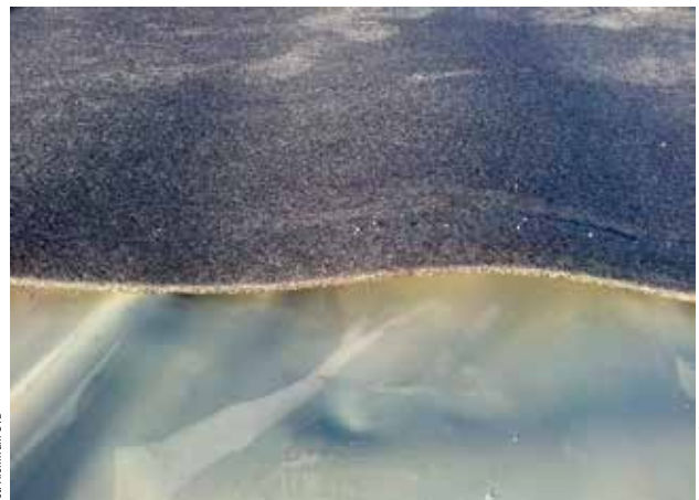
Fot. 2. Przykrycie grubą folią budowlaną i matą piankową docieplającą
