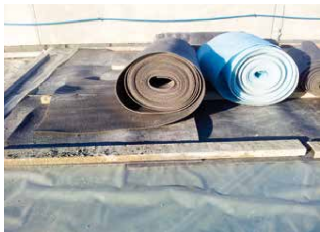
Fot. 3. Przykrycie grubą folią budowlaną i matą piankową docieplającą
