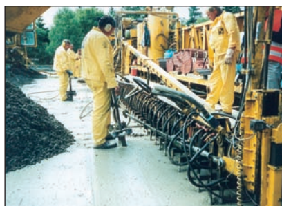
Fot. 3. Zespół roboczy maszyny układającej mieszankę betonową w momencie wvibrowywania elementów łączących poszczególne płyty w kierunku podłużnym – dybli. Ręcznie w wyznaczonych miejscach wvibrowywane są stalowe elementy łączące – kotwy
