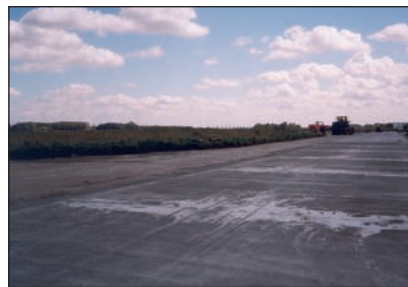
Fot. 7. Fragment betonowej nawierzchni lotniskowej wykonanej w szalunkach zagęszczonej listwą wibracyjną ( białe pasma na nawierzchni to rezultat wyptywającego „szlamu” powstającego podczas wykonywania szczelin ).
