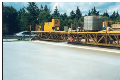
Fot. 4. Fragment nawierzchni drogowej budowanej metodą ślizgową na całą szerokość pasa drogowego o szerokości około 15 m, po przejściu zespołu układającego i po wykonaniu koniecznych czynności fakturowania i hydrofobowego zabezpieczenia nawierzchni
