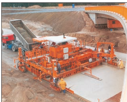
Fot. 6. Fragment budowanej betonowej nawierzchni drogowej szerokości 8,5 m w Niemczech.
