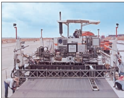
Fot. 5. Zespół układający nawierzchnię betonową model SP-500 Virtgen metodą ślizgową pasem o szerokości 5,0 m na lotnisku w Kuala Lumpur
